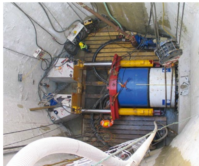
Startschacht, Paris, Frankreich
