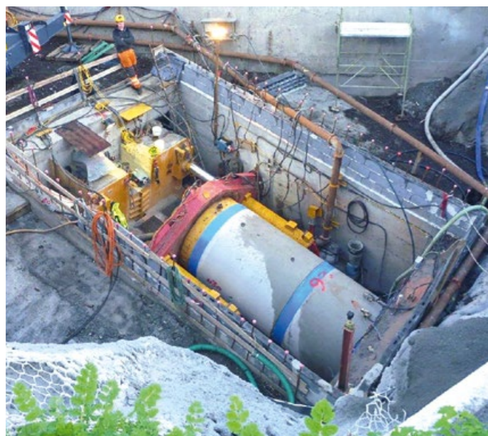
Startschacht in Catania, Italien
