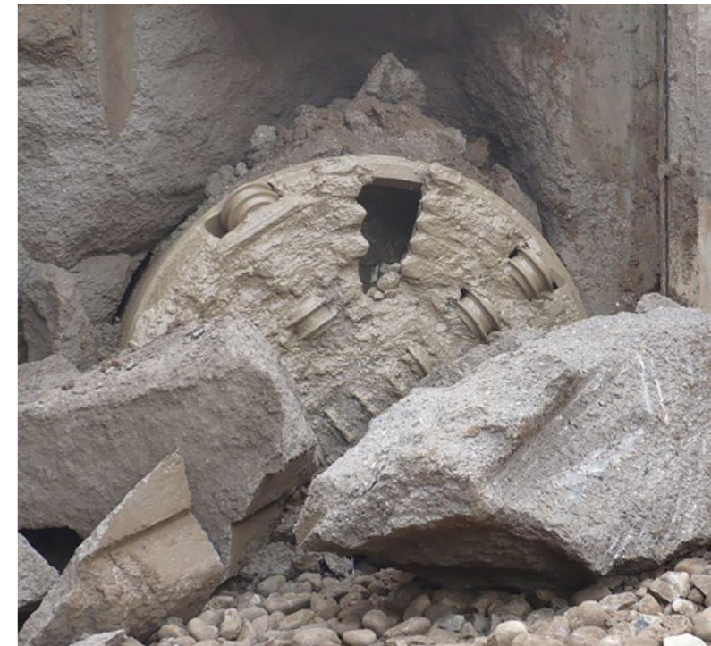
Durchbruch in den Zielschacht, Lissabon, Portugal
